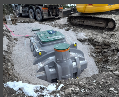
Assainissement ancienne cure de Lains
