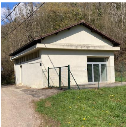
Station d'ultra filtration de Montagna
